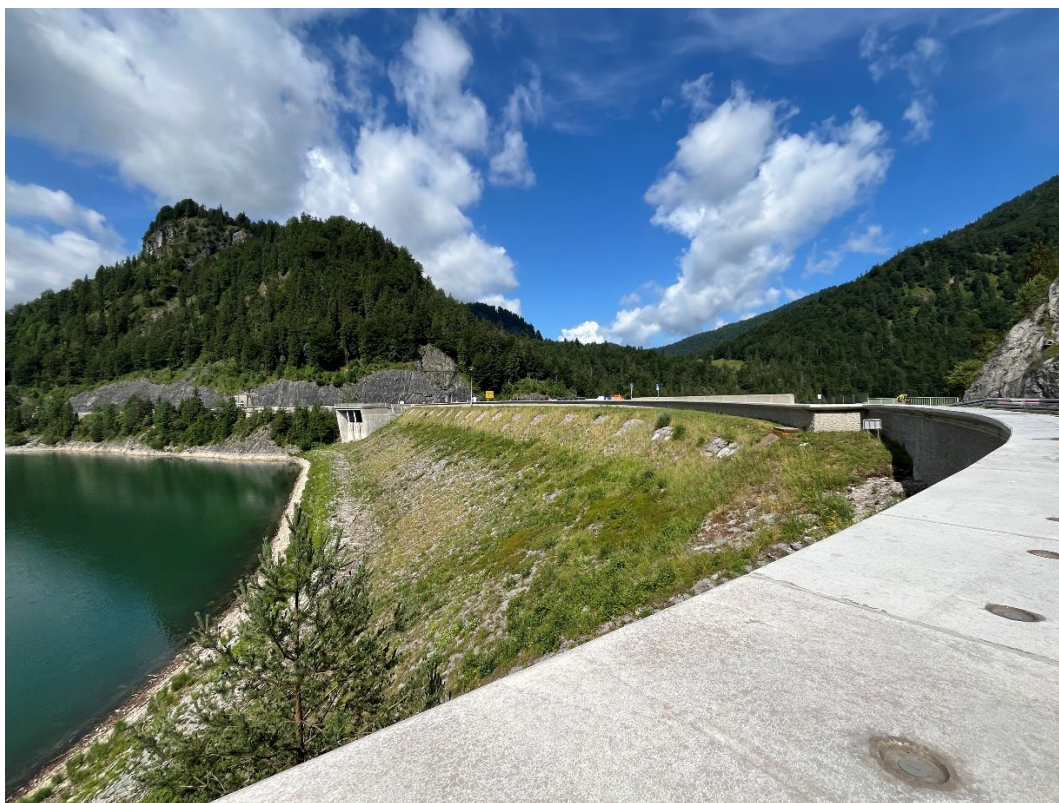
Abbildung 1: Fertiggestellter Wellenabweiser auf der wasserseitigen Kronenmauer.
