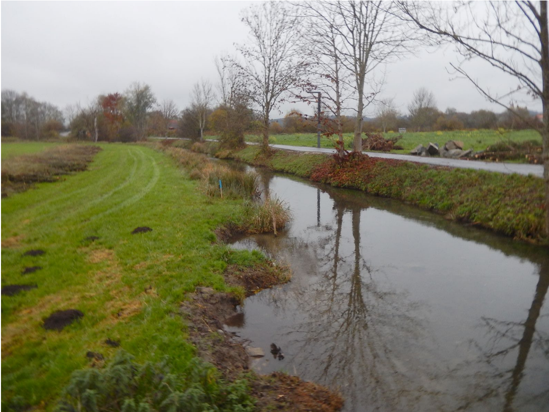
Abb. 2: Abschnitt vor Kursbeginn, naturnahe Ufersicherung am Tiefenbach
