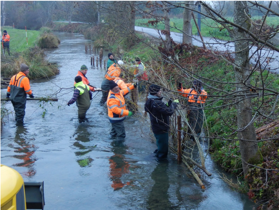
Abb. 1: Flechtwerk einbringen als naturnahe Ufersicherung am Tiefenbach
