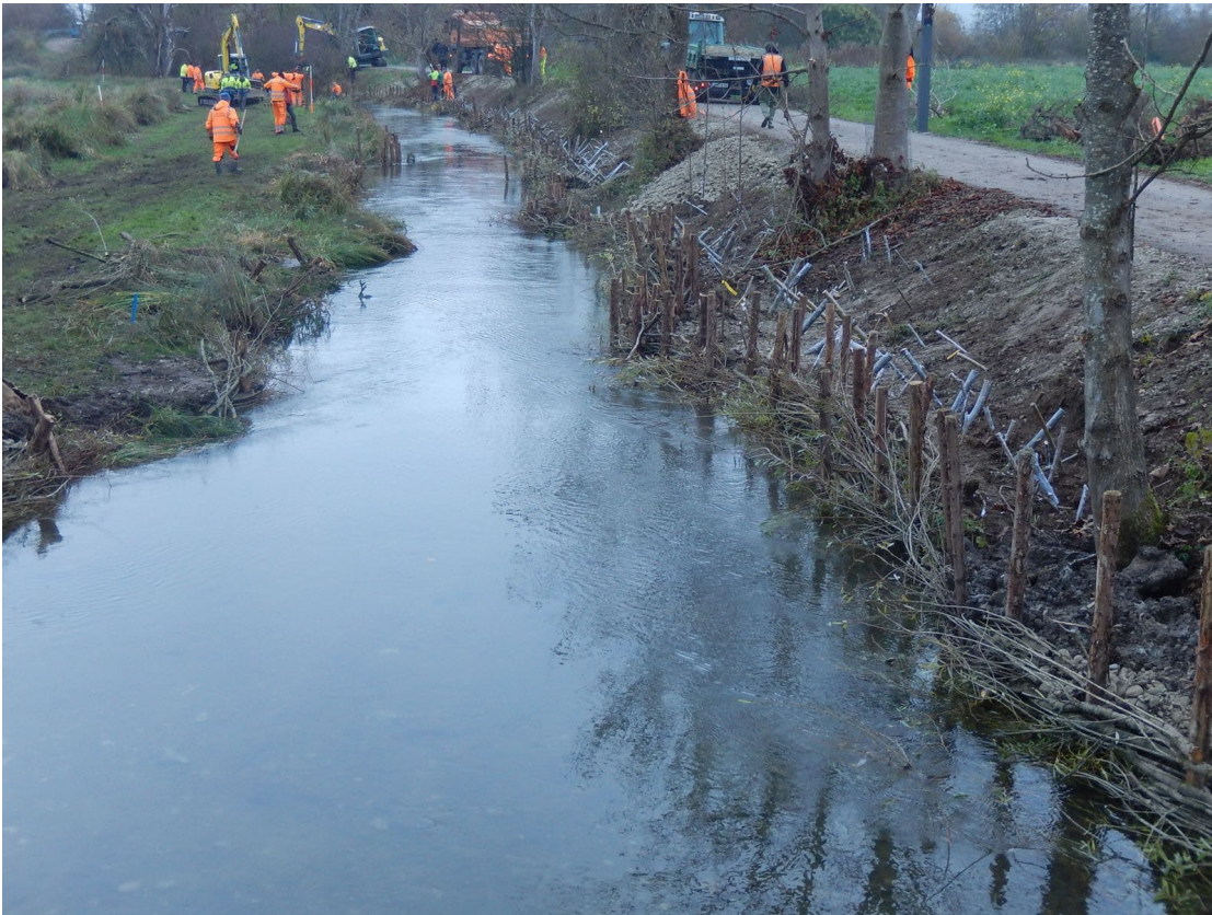
Abb. 3: Abschnitt während Maßnahmenumsetzung am Tiefenbach
