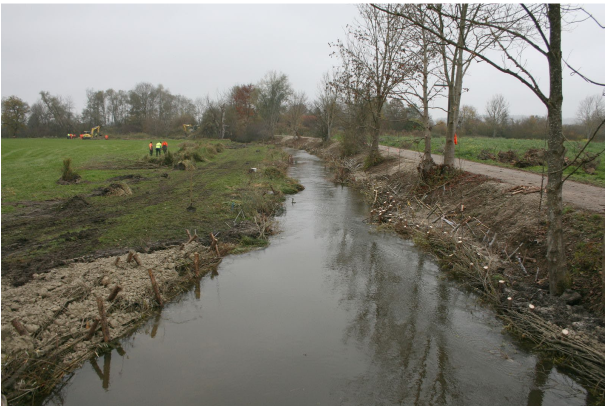
Abb. 4: Abschnitt bei Kursende, naturnahe Ufersicherung am Tiefenbach
