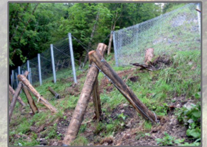
Kriechschneesicherung durch Dreibeinböcke
