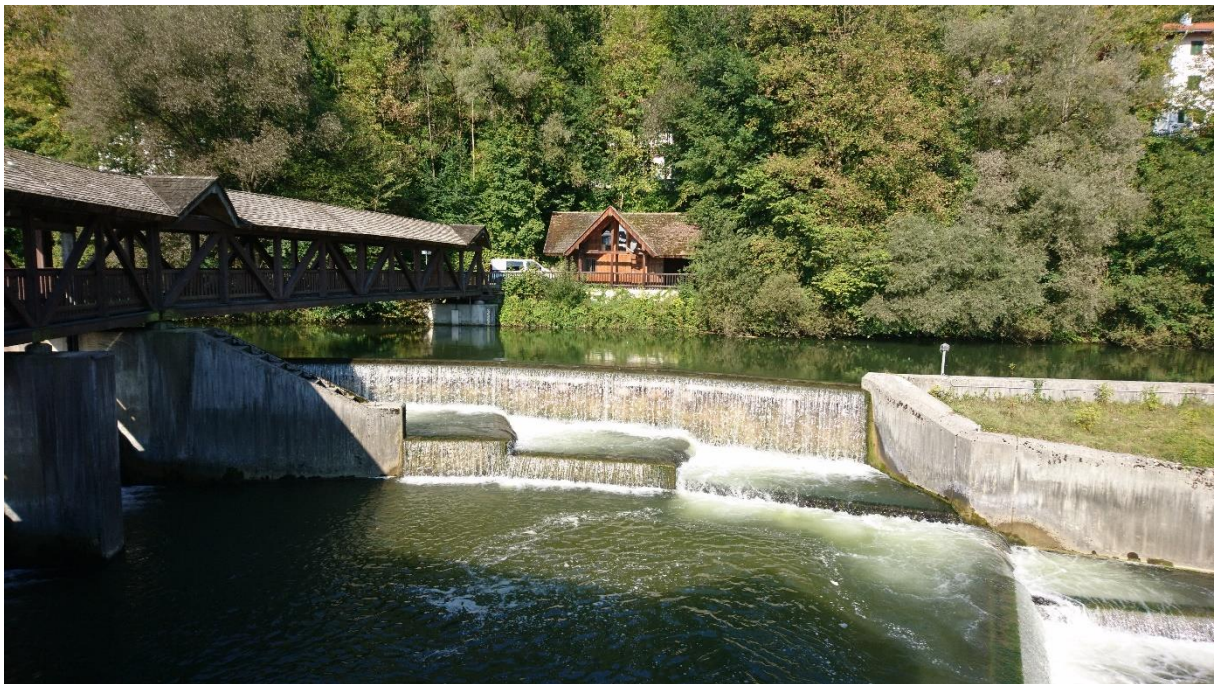
Abb. 9: Eingeschränkte Durchgängigkeit bei Stauanlage Wolfratshausen bei Fkm 2,00
