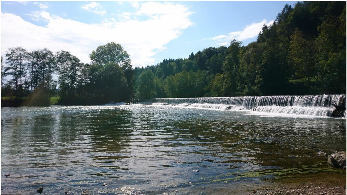
Abb. 10: Fehlende Durchgängigkeit bei Stauanlage Eurasburg bei Fkm 13,80
