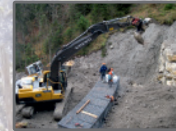
Drahtschotterkastensperre im Bau
