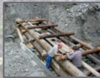
Holzkastensperre im Bau
