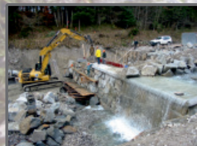
Betonsperrre im Bau
