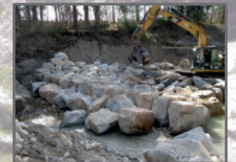
Sohlrampe im Bau
