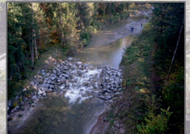
Sohlrampe im Steinbach, Gemeinde Bichl
