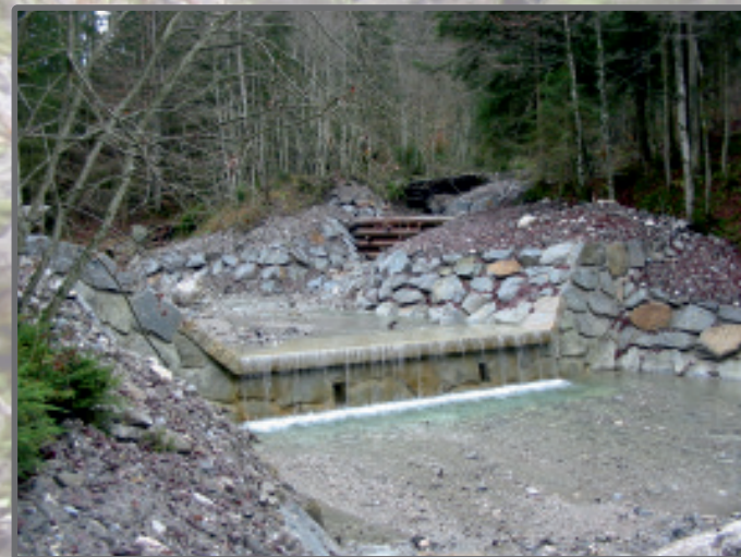
Betonsperrre mit Steinverblendung im Steinbach, Gemeinde Bichl
