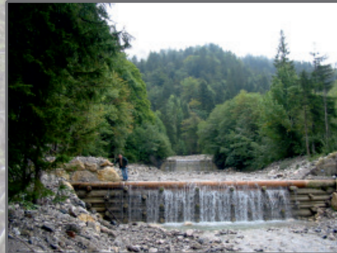
Holzkastensperre am Pessenbach, Gemeinde Kochel
