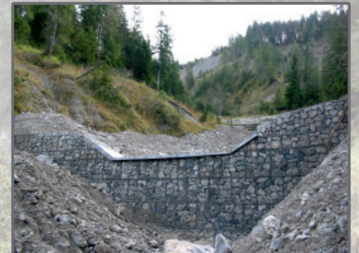
Drahtschotterkastensperre in der Melcherreißer, Gemeinde Benediktbeuern
