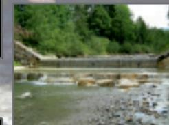
Absturzbauwerk im Lainbach zur Stabilisierung der Gewässerschleife
