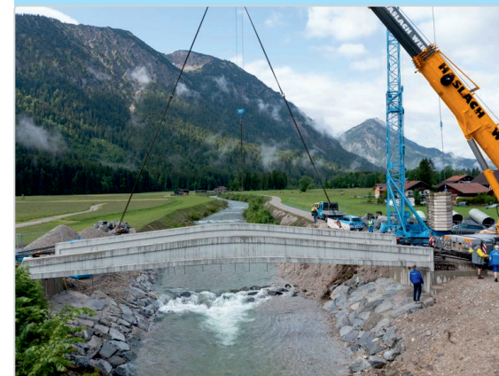
Einheben des neuen Brückenelements über die Linder im Zuge des Hochwasserschutzes Graswang, Gemeinde Ettal
