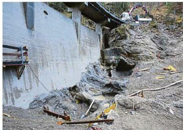
Derzeit werden Hohlräume im Fels, die über die Jahrzehnte entstanden sind, verfüllt, um die Standsicherheit des Bauwerks zu erhalten.
