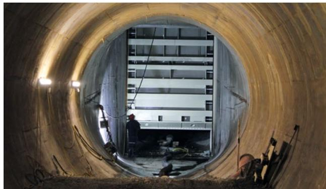
**Bild 6:** Erneuerung des Stahlwasserbaus, Ober-Schütz im Grundablass
