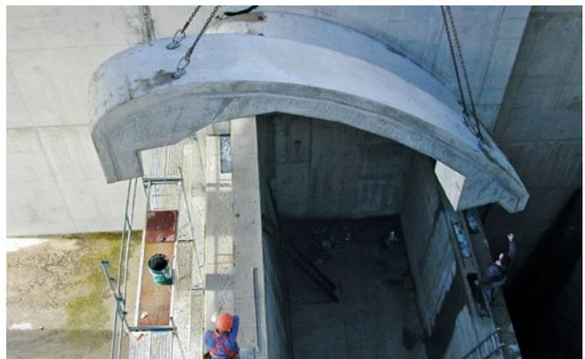
**Bild 5:** Wiedereinsetzen der einzelnen Segmente der Überfallschwelle an der neuen HWE (nach Erhöhung)
