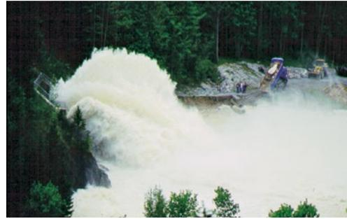
**Bild 2b:** Neue HWE: Erster Einsatz der neuen HWE mit 260 m<sup>3</sup>/s über die Sprungschanze am 23.05.1999
