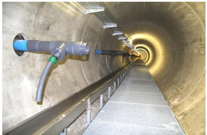
Abb. 26: Blick in den Kontrollgang mit Sickerwassersammelsystem und Innenausbau
