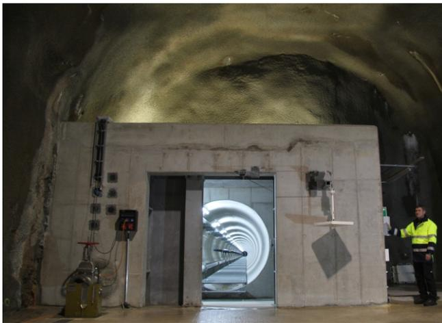
Abb. 24: Blick aus der Kaverne durch das Druckschott in den Kontrollgang mit Innenausbau
