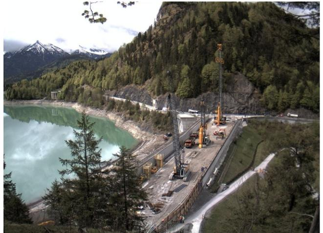
Die Baustelle war als 5-Tage-Woche im 24 h Schichtbetrieb organisiert (Abb 11). Die mittleren Abteufzeiten für einen 70 m tiefen Schlitz lagen bei rund 24 h, der Betoniervorgang benötigte etwa 12 h. Damit konnten durchschnittlich vier Lamellen pro Arbeitswoche hergestellt werden. Der gesamte Bauabschnitt wurde zwischen April und November 2012 ausgeführt, die Schlitzwandarbeiten selbst dauerten von Mai bis August.
