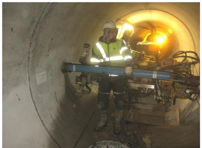
Abb. 23: Vom Kontrollgang aus werden die Sickerwasserpfähle angebohrt. Anschließend wird die Sickerwasserleitung eingebaut.
