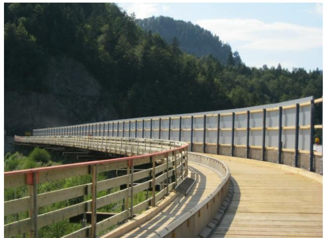
Abb. 4: Behelfsbrücke zur Umfahrung der Dammkrone während der Dichtwandherstellung
