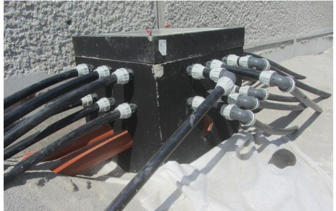
Abb. 25: Schacht zur Verteilung des Spülwassers für die Drainagepfähle
