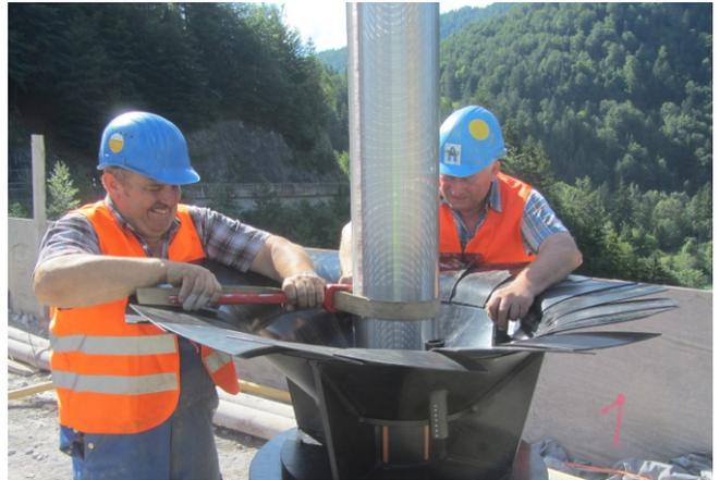
Abb. 22: Vorbereitung zum Einbau des Filters (Schlitzbrückenfilter und Sumpfrohr)
