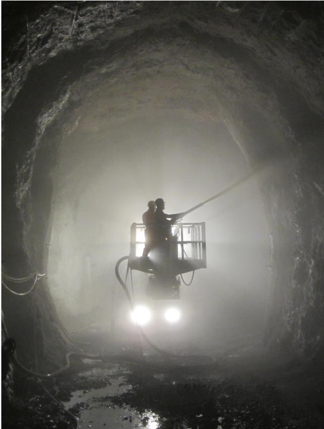
Abb. 14: Sicherung der Startkaverne mit Spritzbeton vor dem Einbau der Presseneinrichtung
