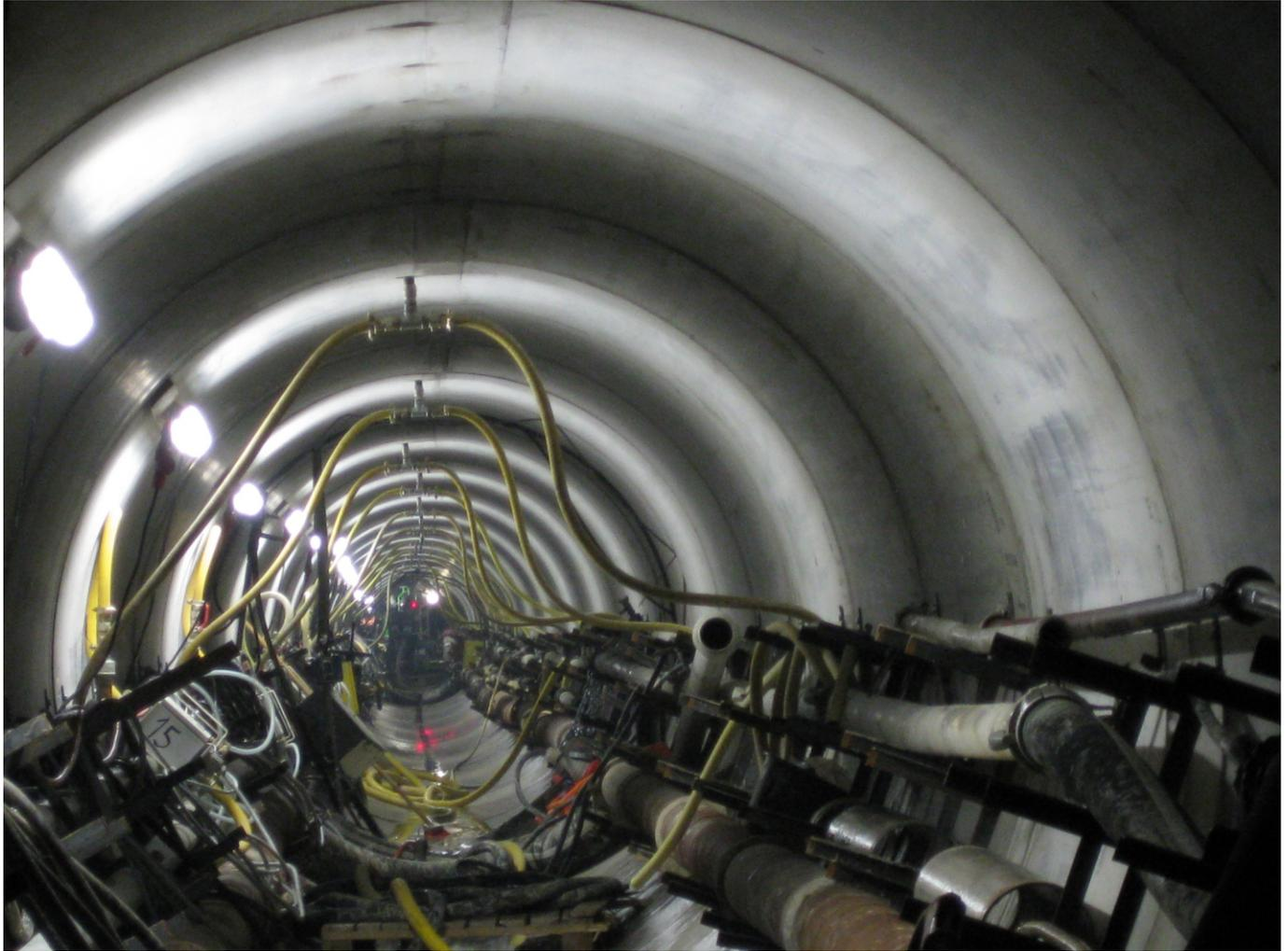
Abb. 17: Stollenvortrieb, Laser, Transport- und Versorgungsleitungen. Die Bentonit-Injektion zur Reduzierung der Mantelreibung erfolgt über die gelbe Injektionsleitung an Firse und Ulmen
