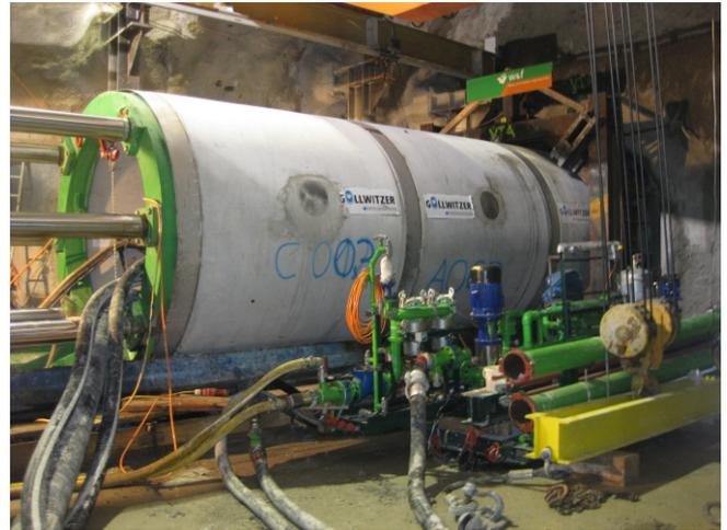
Abb. 16: Die ersten Rohre folgen der bereits durch den Sylvensteinfelsen gefahrenen TBM in den Dammbereich
