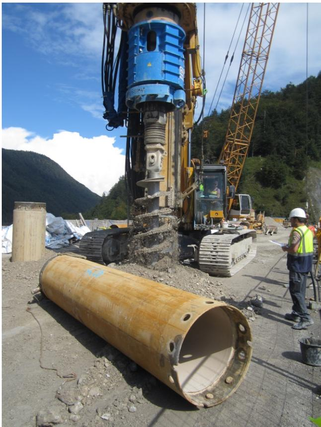
Abb. 21: Bohrpfahlherstellung mit Rohrtour und Bohrschnecke
