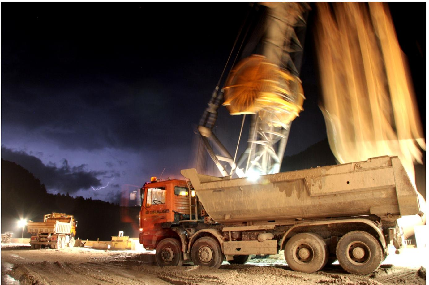
Abb. 11: Die Wetterverhältnisse während der Dichtwandherstellung führen zu teilweise schwierigen Randbedingungen (Blitzschlaggefahr, Niederschläge, Verteilung des Bentonits, Straßenreinigung etc.)
