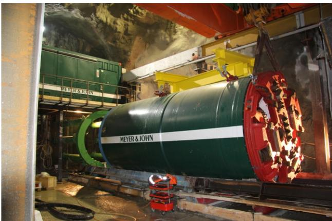
Abb. 13: Montage der Tunnelbohrmaschine (TBM) auf der Schildwiege, dahinter Presseneinrichtung mit 6 Hydraulikzylindern für 2.500 t Schubkraft, darüber Steuerstand für den Vortrieb
