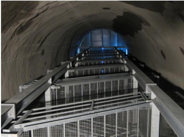
Abb. 19: Der zum Ausbau der Tunnelbohrmaschine benötigte Zielschacht dient künftig als Fluchtweg; hierfür wurde ein rund 40 m hoher Treppenturm eingebaut.
