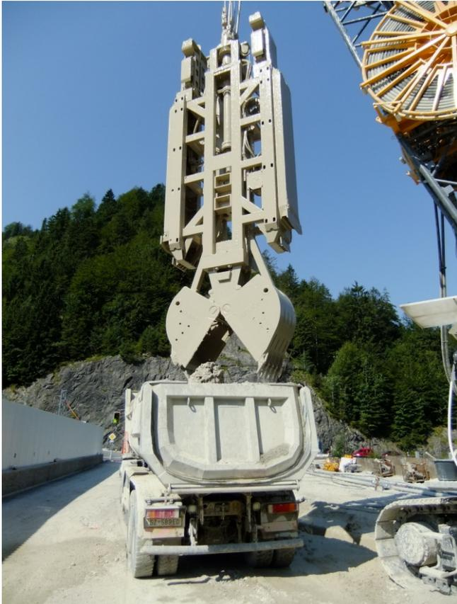
Abb. 8: Schlitzwandgreifer und Schlitzwandfräse der Firma Bauer Spezialtiefbau im Einsatz
