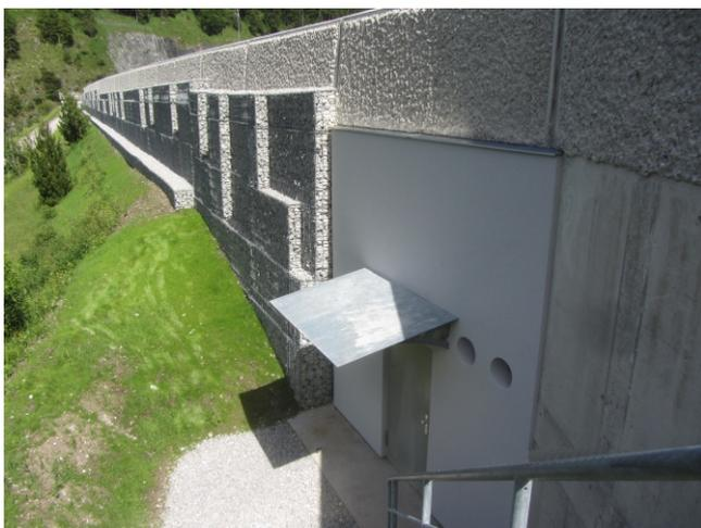
Abb. 28: Luftseitige Struktur der Kronenmauer mit gestockter Betonoberfläche und vorgesetzten Gabionen (Reptilienhabitate)
