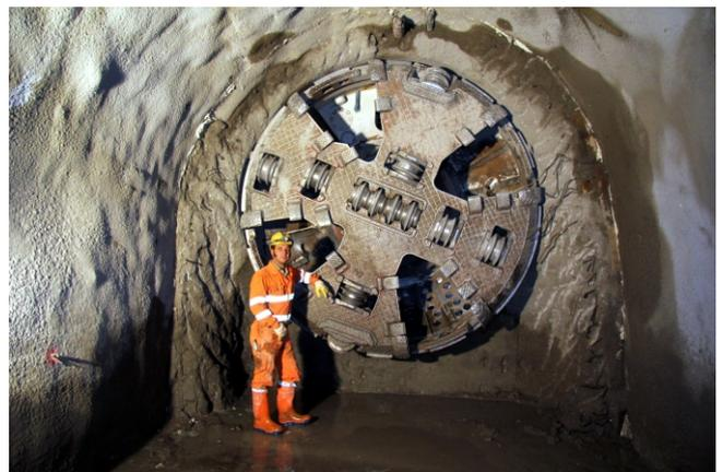
Abb. 18: Bohrkopf der TBM in der Zielkaverne nach Durchörtern der rund 175 m langen Stollenstrecke
