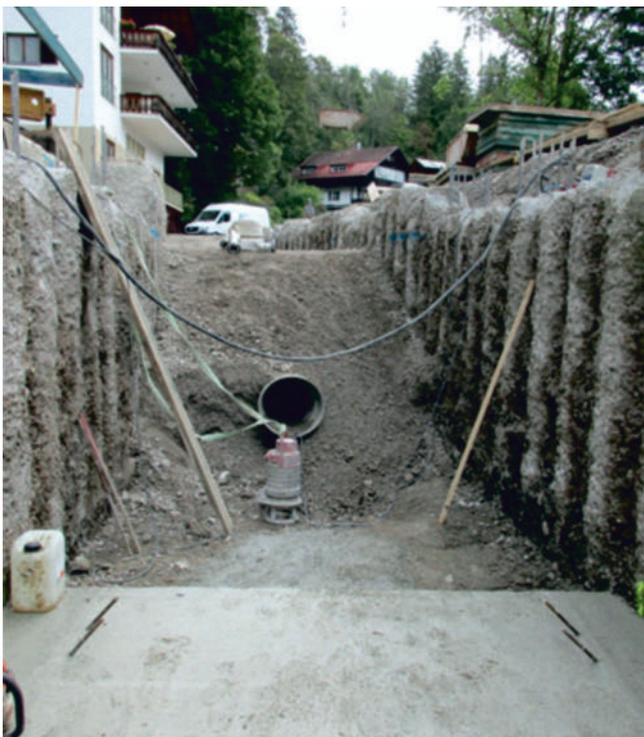
Bohrpfähleihen zur Sicherung des Gerinnes
