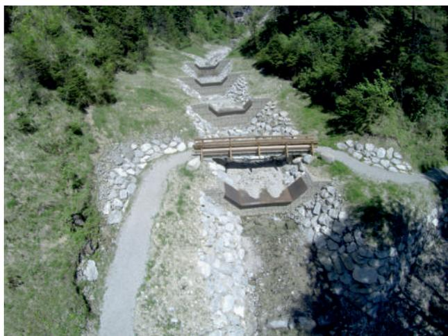
Seit Sommer 2012 wurden vier Gabionensperren und eine Betonsperre errichtet
