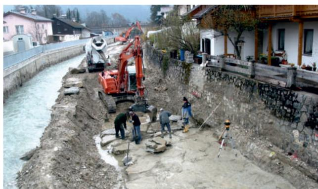
Erstellung der Sohlpflasterung unter stark beengten Verhältnissen bei gleichzeitiger Wasserhaltung innerhalb des Bachbettes
