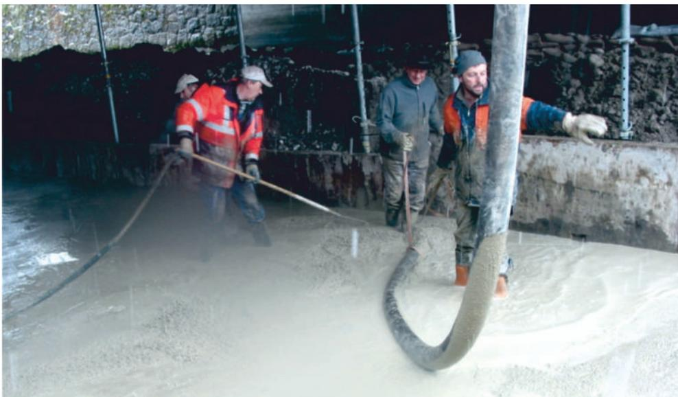
Einbringen des Stahlfaserbetons unter erschwerten Bedingungen
