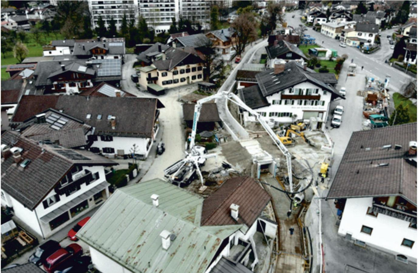
Unterhalb der neugebauten Brücke an der Badgasse wird das Gerinne betoniert
