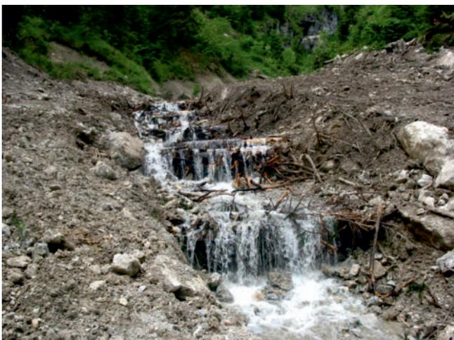
Provisorische Lösung durch Einbringen von Bäumen um die Erosion zu verzögern
