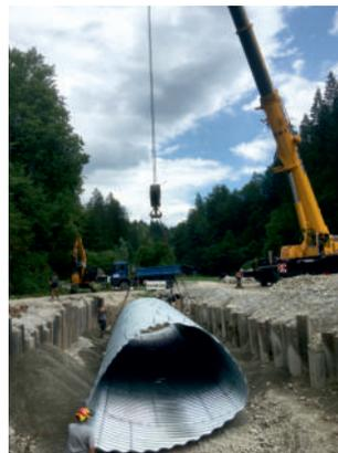
Wellstahldurchlass beim Einheben mit beidseitiger Ufersicherung
