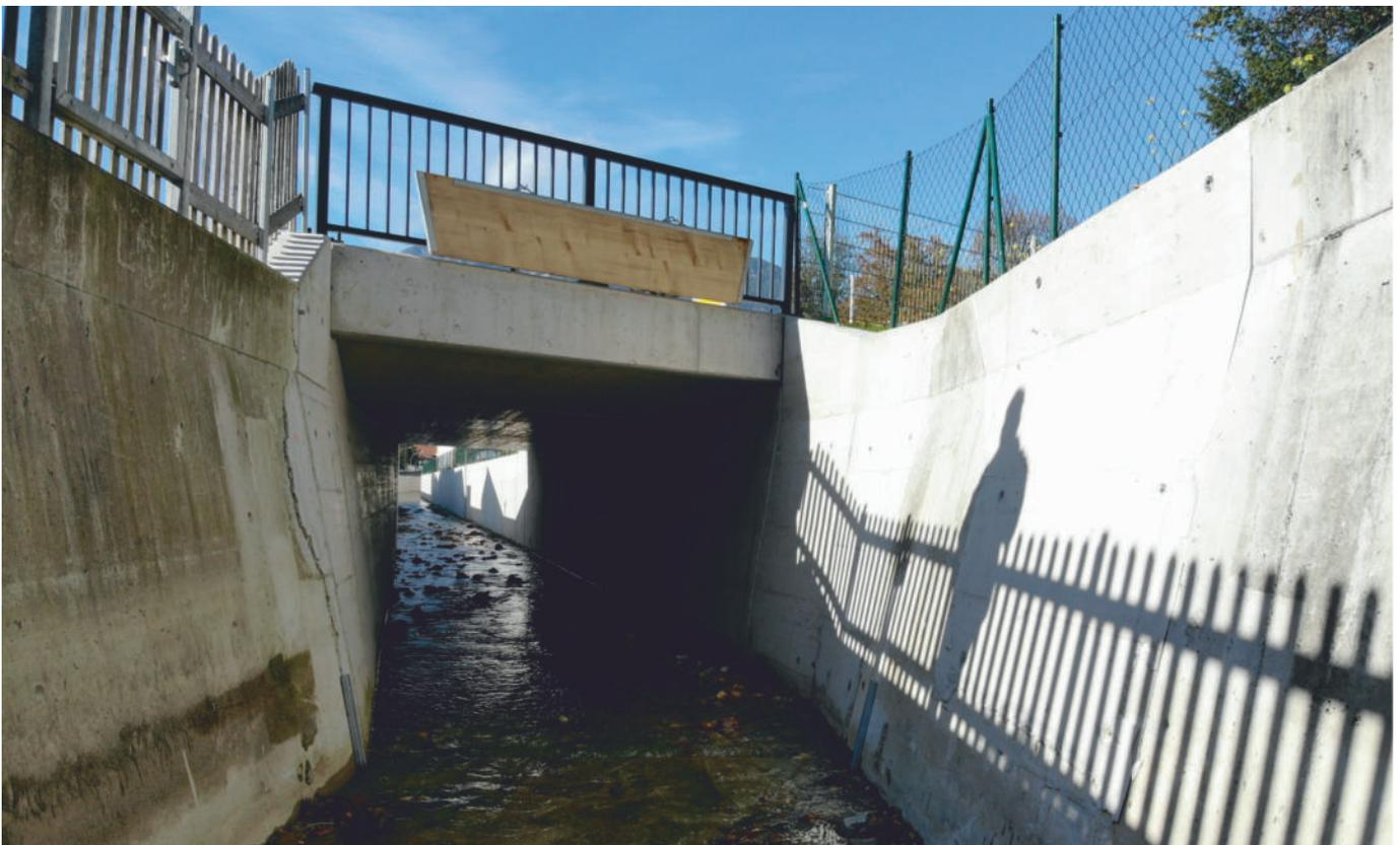
Neue Mittenwalder Straßenbrücke mit Staubrett zum Aufstau der Kanker zur Löschwasserbereitstellung für die Feuerwehr
