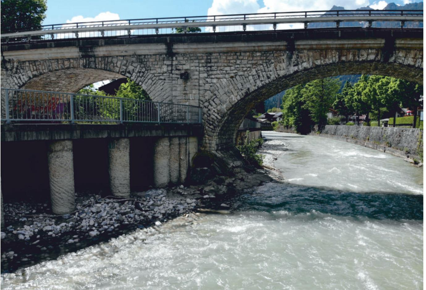
Die Aufweitung des Gerinnes durch das Öffnen eines Brückenfeldes der Eisenbahnbrücke für einen Bypass hat sich bei Hochwasserereignissen bewährt
