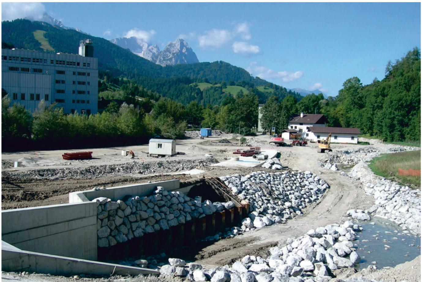
Steinsatzarbeiten am Kankerauslauf (Tosbecken); links der Anfang der Teilüberleitung
