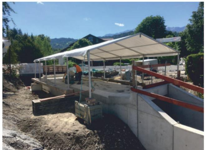
Schutz der Abdichtungsarbeiten der Brücke vor Hitze und Regen mit einem Festzelt!
