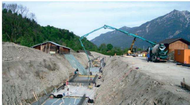
Segmentweises Betonieren der Sohle
