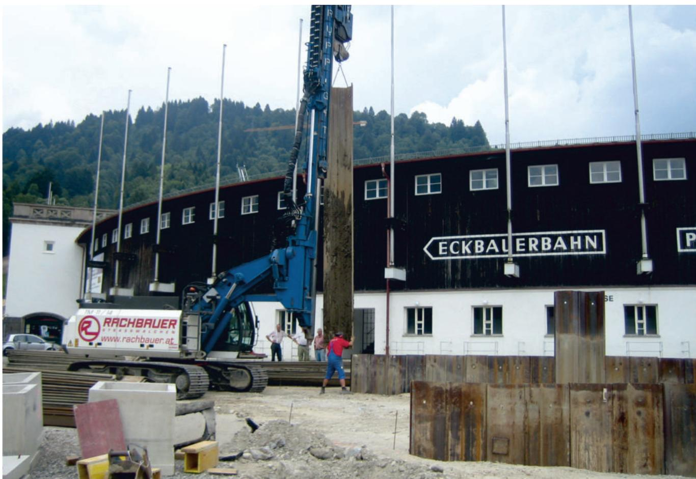
Absicherung der Baugrube durch Stahlspundwände
