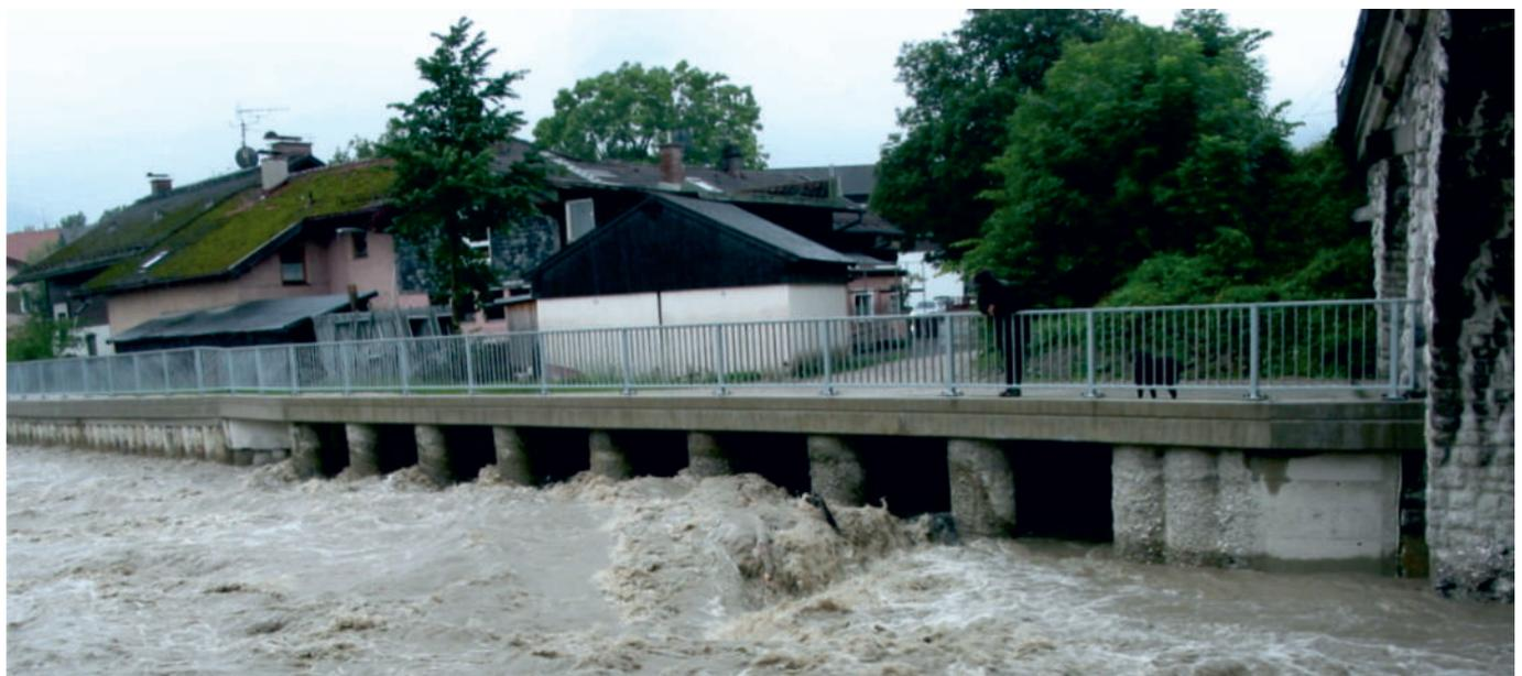
Im Bereich der Ausbaustrecke an der Partnach stellen insgesamt elf Brücken und zahlreiche Leitungsquerungen die Wasserbauer immer wieder vor neue Herausforderungen. Um die Rauigkeit unter den Brücken für mehr Abflussvermögen zu erhöhen wurde unter den Brücken gepflastert oder wie an der Von-Brug-Straßenbrücke mit Stahlfaserbeton betoniert.
