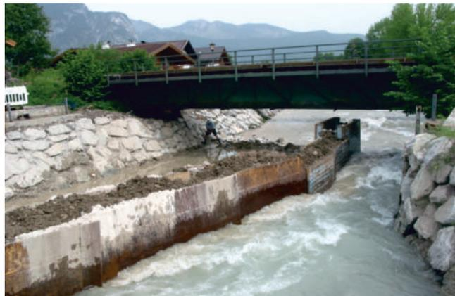
Wasserhaltung beim Neubau der Ufersicherungen an der Partnach unterhalb der Mündung der Teilüberleitung der Kanker
