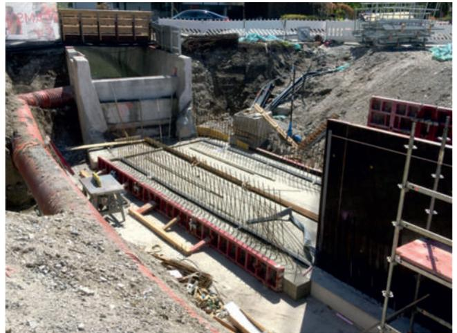
Anschluss des Gerinnes an das fertige Brückenfundament
