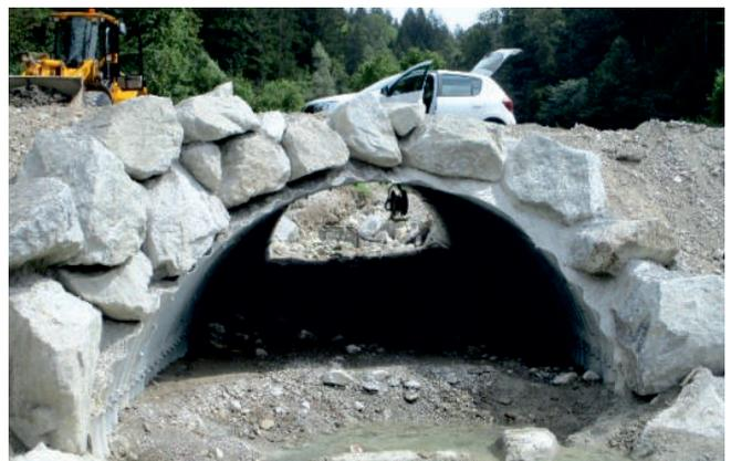
Neue Brücke des Unterhaltungsweges mit eingebautem Wellstahldurchlass
