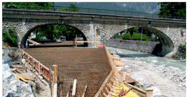
Betonieren der Abdeckung des Bypasses
