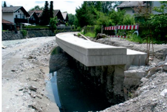
Sicherung des Ufers mit einer Bohrpfehlwand und Aufweitung des Gerinnes durch den auskragenden Gehweg
