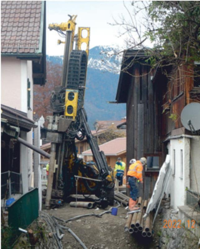
An der engsten Stelle kurz oberhalb der Schornstraßenbrücke wurden zur Abstützung der Häuser Mikropfähle gebohrt
