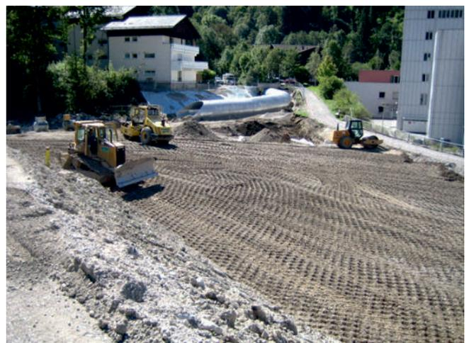
Lagenweiser Einbau des Dammbau-Materials und Verdichten mit der Schafffußwalze; im Hintergrund der Wellstahldurchlass vom Wamberger Graben
