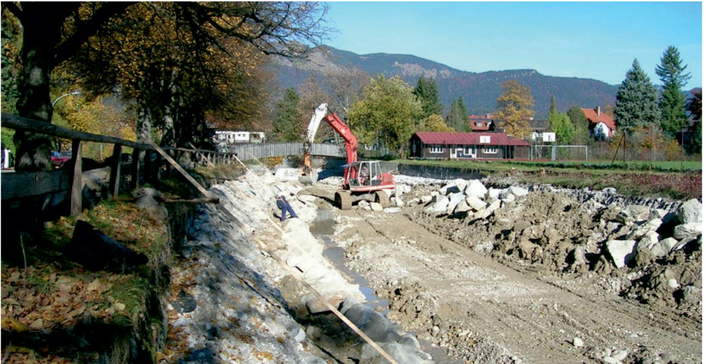
Setzen der Wasserbausteine für die Ufersicherung
