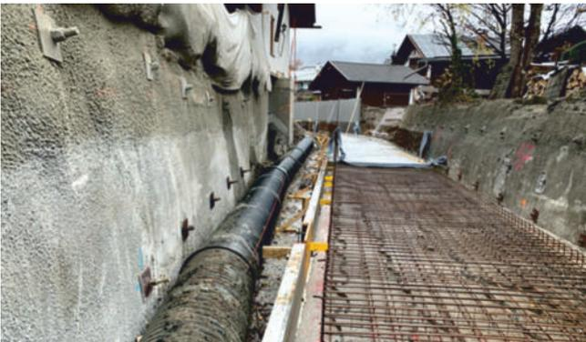
Auf größere Längen konnte das Wasser der Kanker in Rohrleitungen im jeweiligen Bauabschnitt vorbeigeleitet werden
