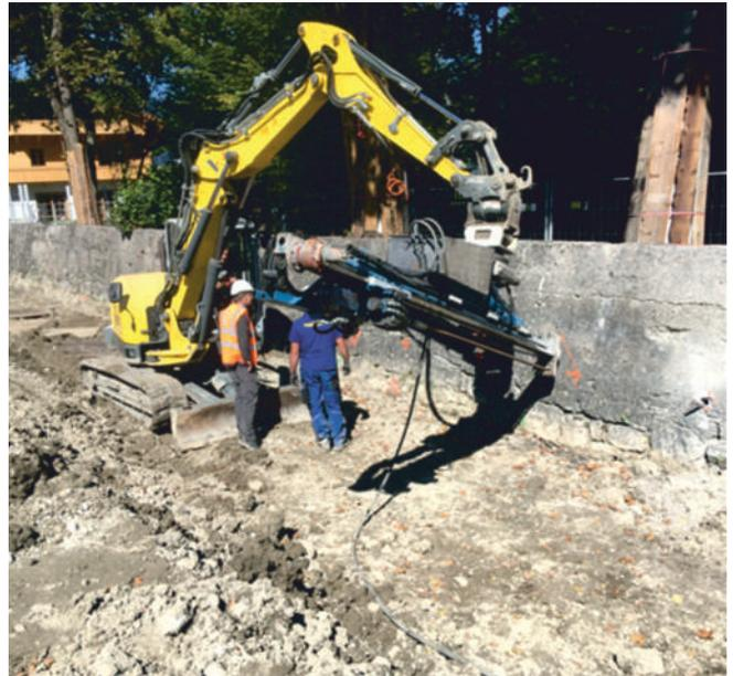
Auch im letzten Sanierungsabschnitt des BA 03 der Kanker musste die Baugrube mit rückverankerten Spritzbetonwänden gesichert werden
