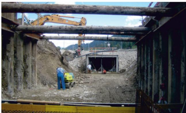
Segmentweises Betonieren der Wände und Decke des Betongerinnes
