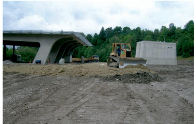
Schütten des Dammbaumaterials. Im Hintergrund links der Hubschrauberlandeplatz des Klinikums, rechts das betonierte Schützenhaus (Schützenkammer)
