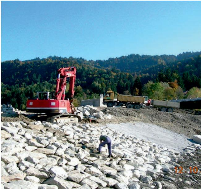
Steinsatzarbeiten an der Hochwasserentlastungsschwelle
