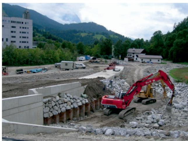
Anschluss des Betongerinnes der Überleitung an den Damm
