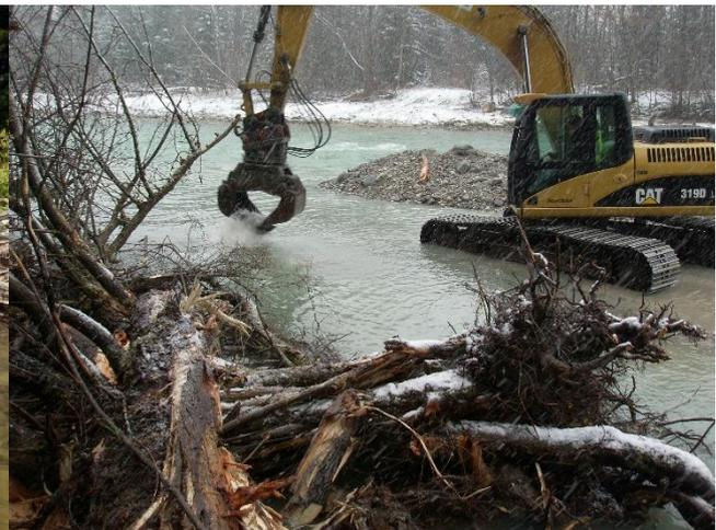
**Abbildung 65: Isar Fkm 195,4: künstliche Herstellung eines Jungfisch-Wintereinstands aus dicht gepacktem Totholz (Foto: H. Henkel)**
