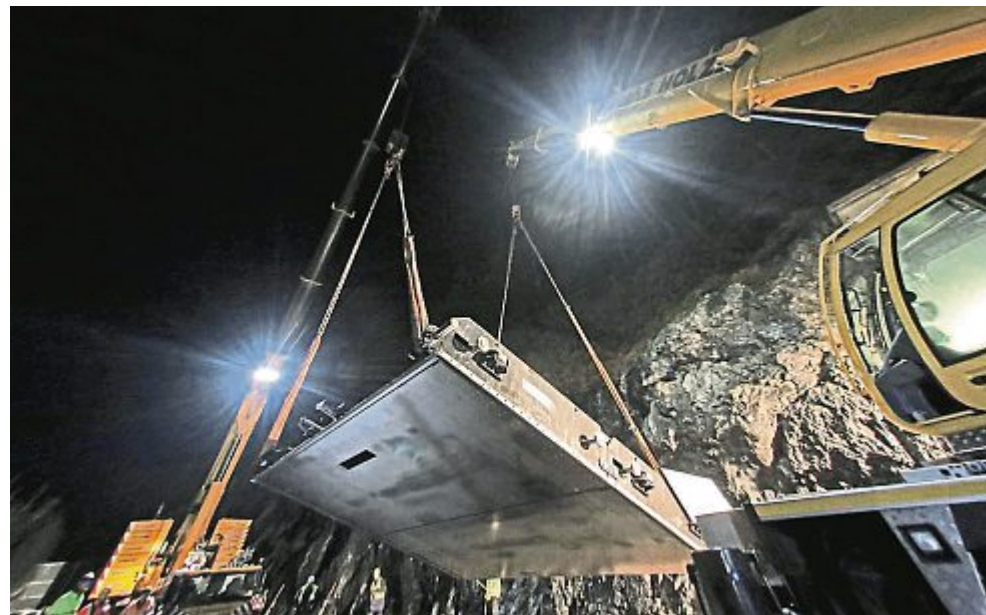
Ein 21 Tonnen schwere Stöpsel: In der Nacht zum Mittwoch wurde am Sylvensteinsee der neue Revisionschütz eingelassen – ein spektakulärer Kraftakt.
