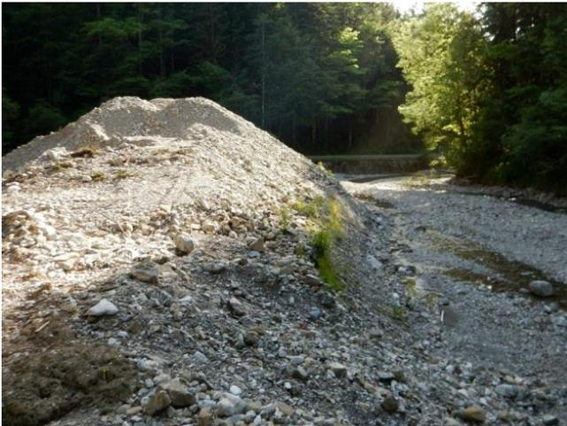
**Abbildung 92: Steinbach (Gaißach): Entnahme von grobem Geschiebe**
