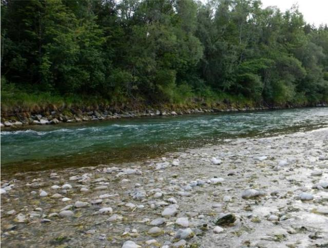
**Abbildung 117:** für einen Rückbau vorgesehene Uferbefestigung entlang tiefer Kolkrinne (U4/Fkm 194,03)
