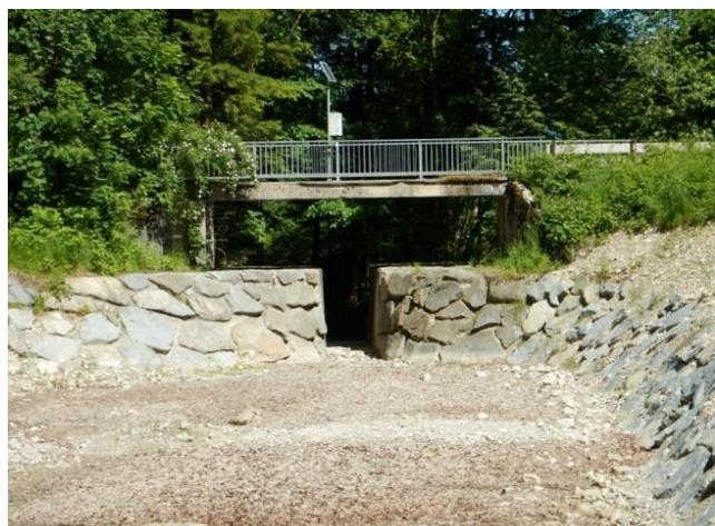
**Abbildung 101: Steinbach (Wackersberg): mit neuer Geschiebedosiersperre**
