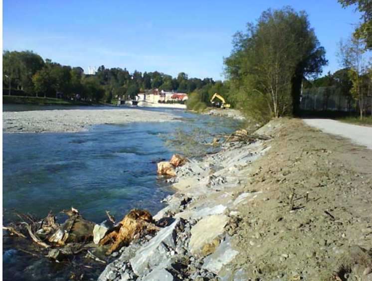
Abbildung 13: Sanierung und Umgestaltung des Uferschutzes der Isar im Stadtgebiet Bad Tölz
