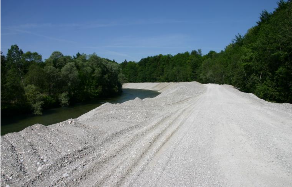
Abbildung 16: Geschiebeumsetzung unterhalb des Kraftwerkes Bad Tölz ( http://www.wwa-wm.bayern.de/projekte_und_programme/aktuelle_projekte/geschiebemanagement_isar/geschiebemanagement_isar_geschiebeumsetzung_toelz/index.htm , Autor: Lechermann [03.05.2011])
