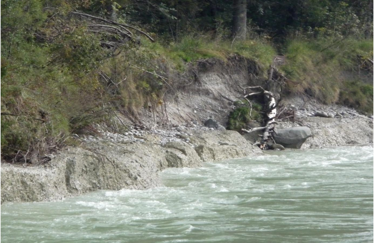
Abbildung 9: Die anstehenden Seetone südlich der Wolfratshauer Brücke leisten großen Widerstand gegenüber der Seitenerosion
