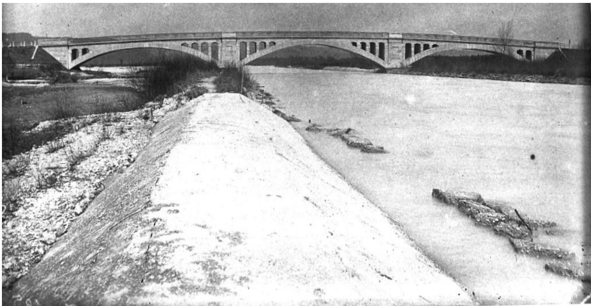
Abbildung 2: Blick auf die alte Marienbrücke im Jahr 1915 als die Ufer bereits befestigt waren (Quelle: WWA Weilheim)
