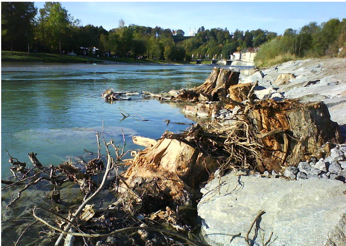
Abbildung 36: Naturnahe Ufersicherung aus Wurzelstöcken und Totholz in Bad Tölz ( http://www.wwa-wm.bayern.de/projekte_und_programme/aktuelle_projekte/geschiebemanagement_isar/geschiebemanagement_isar_uferschutz_toelz/index.htm [10.05.2011])
