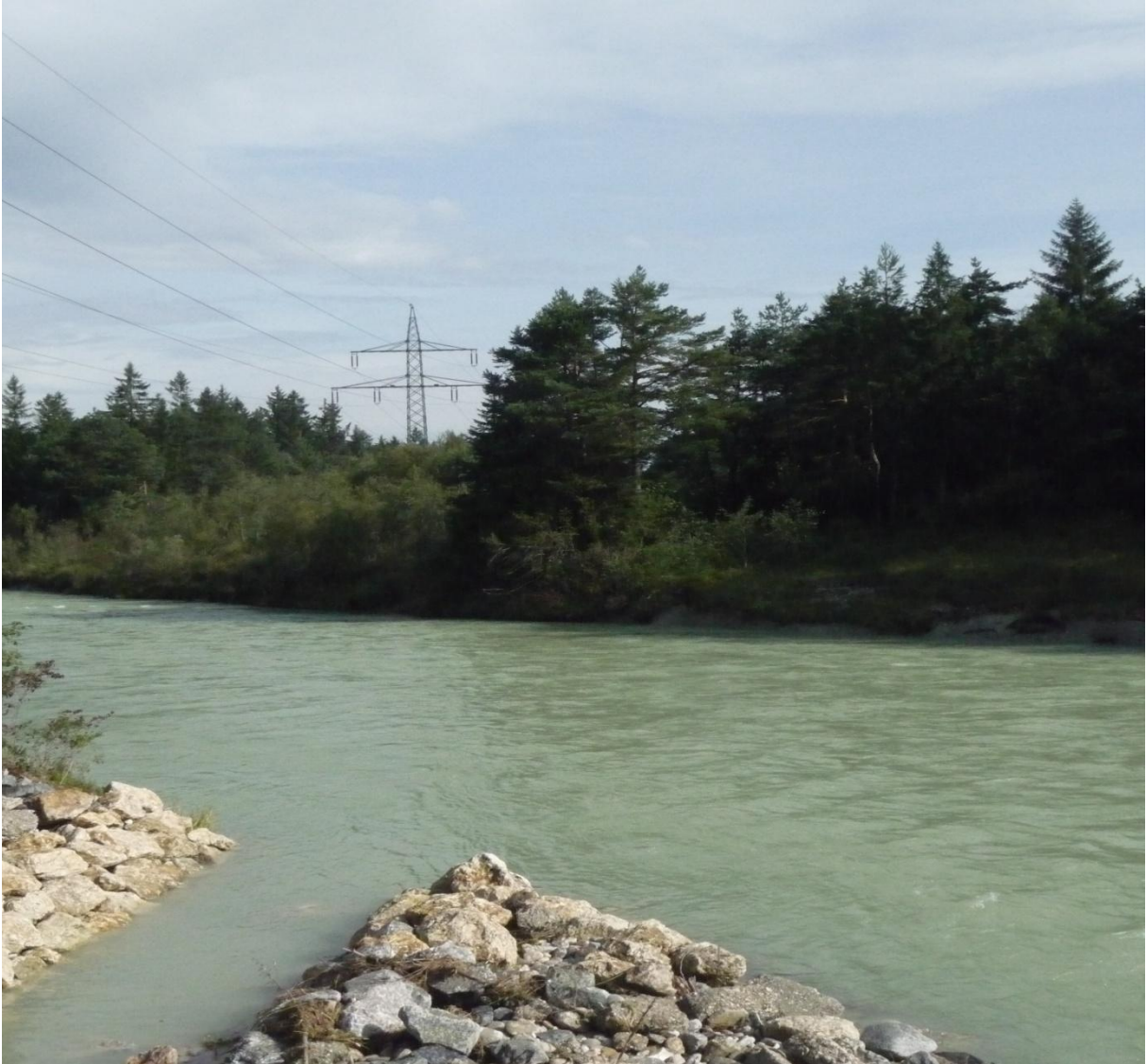
Abbildung 4: Auslaufgraben des Dükers und kreuzende Hochspannungsleitung bei Fkm 177,4 (07.10.2010)
