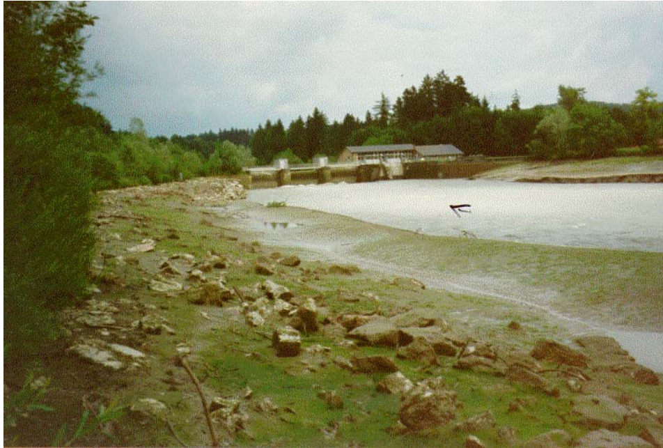
Abbildung 2: Feste Meßstation am Bad Tölzer Wehr
