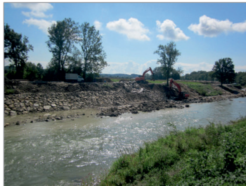
Ufersicherung am rechten Ufer (Hochwasserschutzdeich)
