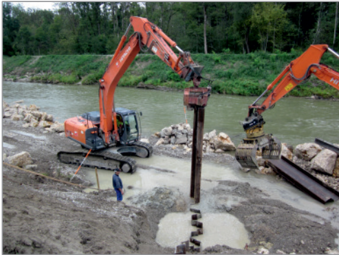
Setzen der Spundwand
