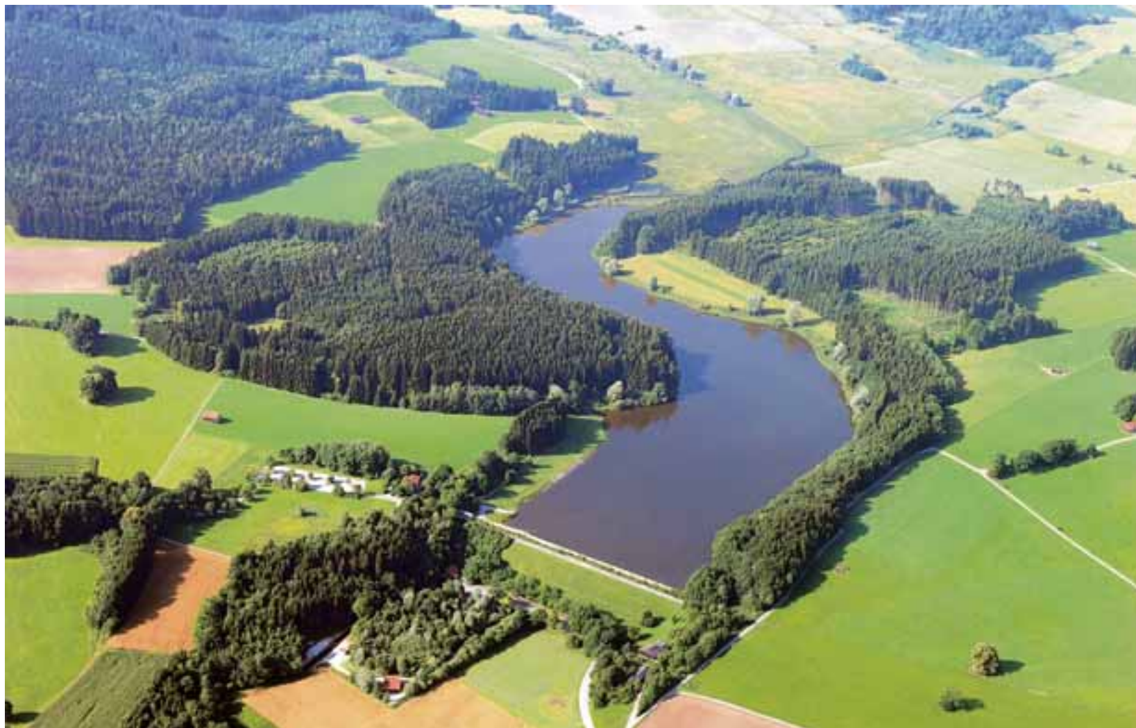
Wo sich einst die Windach schlängelte, liegt jetzt der Speichersee in seinen Ufern, gestaut durch einen Wall im Taldurchbruch, wie auf diesem Luftbild zu erkennen ist. Gen Südwesten, im Bild oben, breitet sich der Stausee bei Hochwasser weiter aus.
