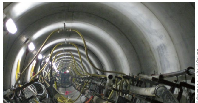
Bild 7: Stollenvortrieb, Laser, Transport- und Versorgungsleitungen, die Bentonit-Injektion zur Reduzierung der Mantelreibung erfolgt über die gelbe Injektionsleitung an Firste und Ulmen
