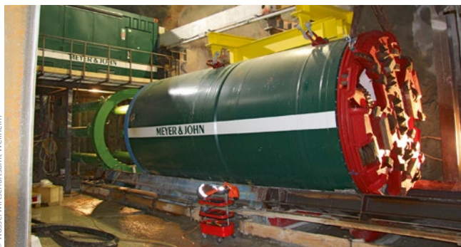
Bild 6: Montage der TBM auf der Schildwiege, dahinter Presseneinrichtung mit sechs Hydraulikzylindern für 2 500 t Schubkraft, darüber Steuerstand für den Vortrieb
