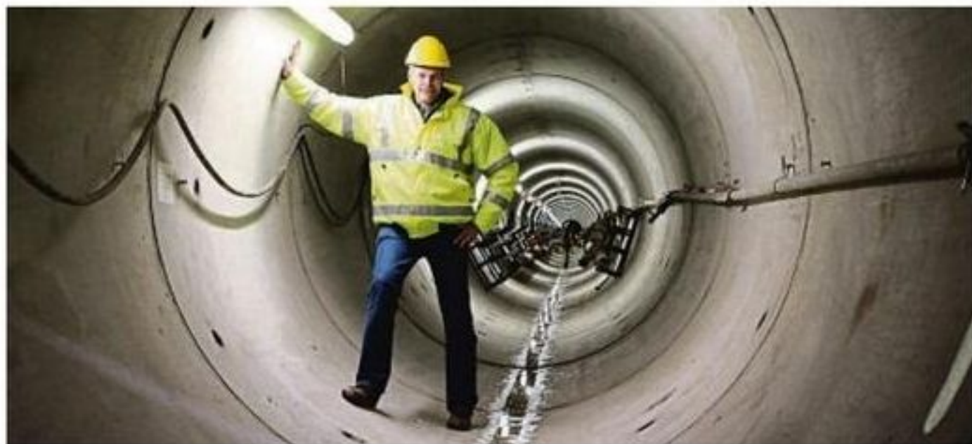
Der Sickerwasser-Stollen (im Bild: Tobias Lang) wurde im vergangenen Jahr gegraben. Heuer werden als Ergänzung noch 54 Drainagepfähle gebohrt, die Aufschluss geben, ob die Dammdichtung irgendwo Wasser durchlässt.
