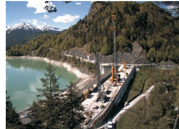
Der Sylvensteindamm mit den Großgeräten im Mai 2012
