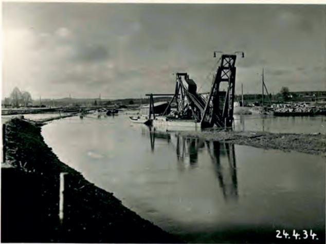
Spülbagger bei der Korrektur im Bereich Maxkron-Fletzen 1934
