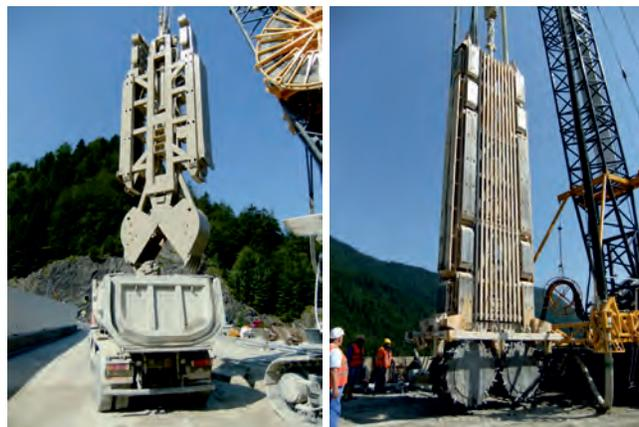
Schlitzwandgreifer und Schlitzwandfräse der Firma Bauer Spezialtiefbau
