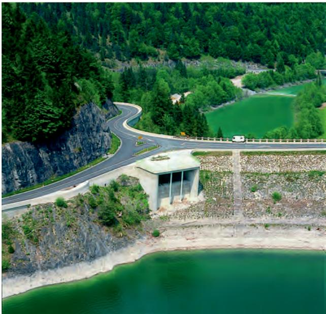
An die Dammerhöhung angepasstes altes Hochwasserentlastungsbauwerk
