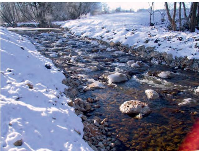
Zur durchgängigen Sohlrampe umgebautes Wehr an der Rott bei Raisting
