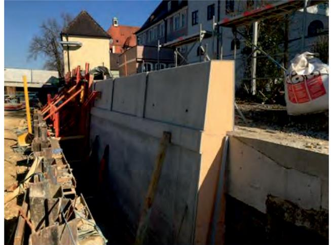
Abschnittsweise Herstellung der vorgesetzten Stahlbetonmauer
