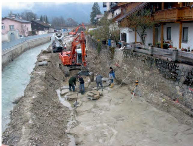
Erstellung der Sohlpflasterung unter stark beengten Verhältnissen bei gleichzeitiger Wasserhaltung innerhalb des Bachbettes
