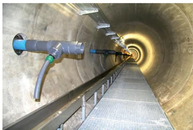
Blick in den Kontrollgang mit Sickerwassersammelsystem und Innenausbau
