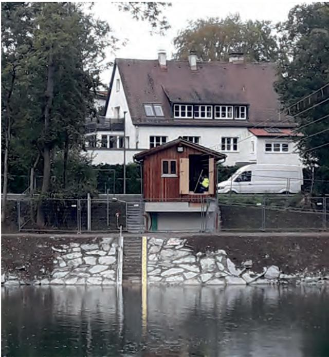
Sanierte Pegelanlage mit neuer Seilkrananlage und angepasstem Pegelhaus
