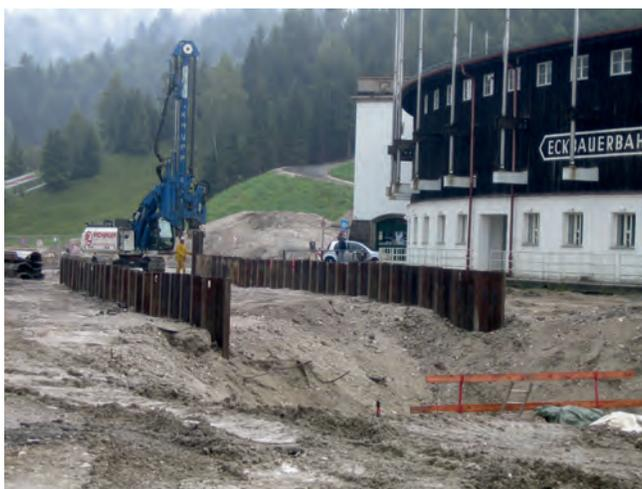
Absicherung der Baugrube durch Stahlspundwände
