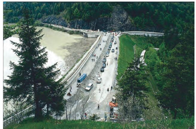
Wesentliche Elemente der Dammerhöhung (Kronenmauer und Kerndichtung) standen beim Hochwasser 1999 bereits zur Verfügung
