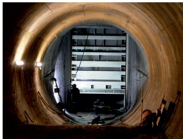
Erneuerung des Stahlwasserbaues, Ober-Schütz im Grundablass
