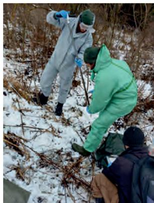
Bau der Grundwassermessstelle WM076 im Abstrom des ehemaligen Weilheimer Gaswerkes auf dem Grundstück des WWA (2001) und Handsondierungen unter Arbeits-schutzbedingungen aufgrund von Milzbrandgefahr
