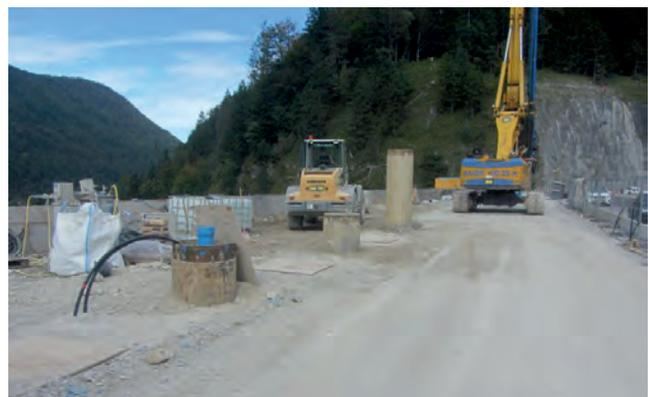
Bohrreihe der Drainagepfähle zwischen Schlitzwand und Kontrollstollen.
