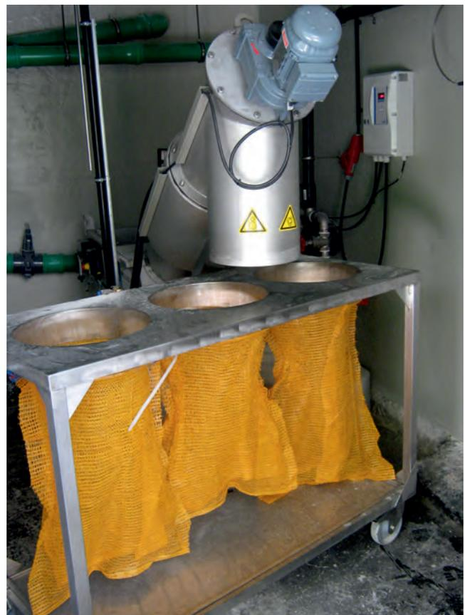
Filtersackanlage nach Schneckenpresse zur Entwässerung
