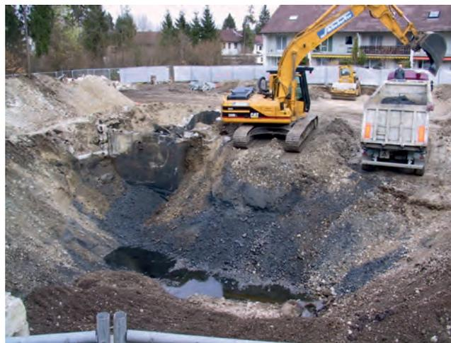
Sanierung einer Altlast durch Auskoffern (Geretsried)
