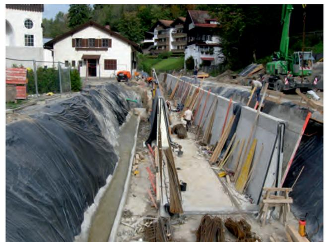
Trotz Steuerung am Hochwasserrückhaltebecken war wegen der Fischerei und des anfallenden Wassers aus dem Zwischeneinzugsgebiet eine Wasserhaltung erforderlich
