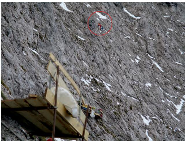
Herstellung der Fundamente für die Sprenganlagen im steilen Fels
