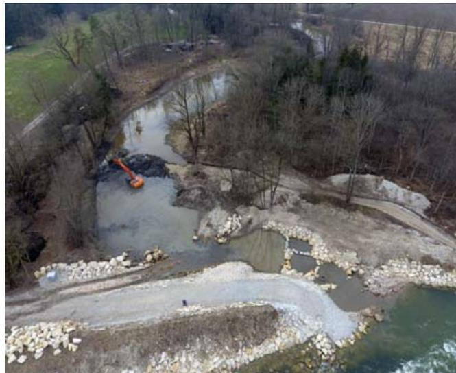
Abb. 7: Anbindung des Ochsenbach-Altwassers
