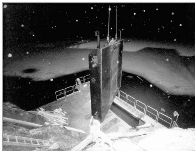
Einbau des neuen Revisionsverschlusses am Triebwasserstollen im Februar 1999
