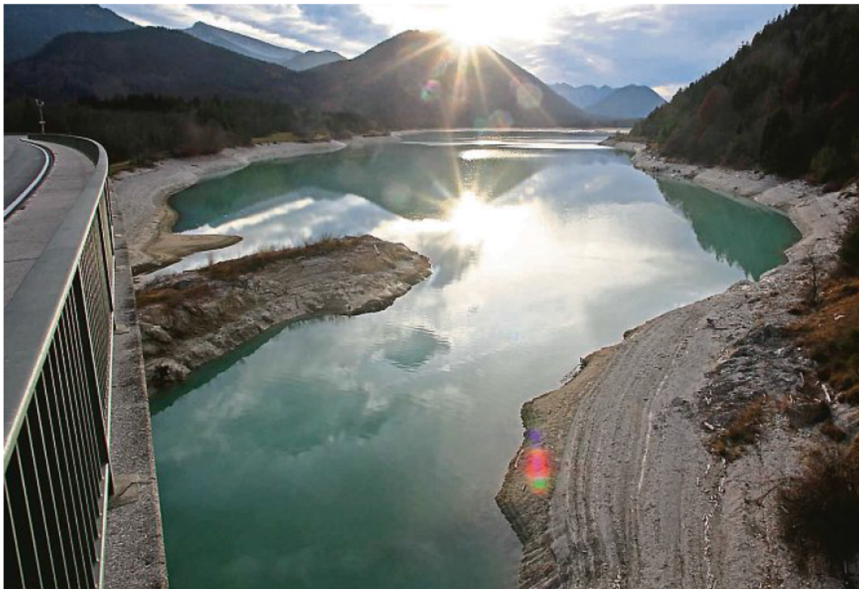
Täglich fällt der Wasserstand im Sylvensteinsee um 30 Zentimeter. Das Wasserwirtschaftsamt hat die Abgabe an die Isar erhöht, weil Arbeiten am Grundablassstollen nötig sind. Zwölf Meter wird er am Ende noch tief sein – normal sind 27. PROHL
